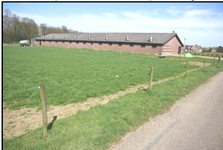
Foto 2: De te slopen varkensstal aan de Kamperdwarsweg 9
