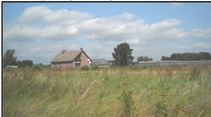
Foto 1: Bedrijfswoning Beckersweg 39, met op achtergrond de te slopen glastuinbouwkas en bedrijfsgebouw
