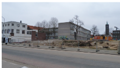
Foto 3 Afgebroken bebouwing zuidwestelijk deel van plangebied, gezien vanaf Maaskade.
