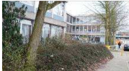
Foto 2 Bebouwing en plantsoen (noord)westzijde plangebied, gezien vanaf Maasschrikkel.
