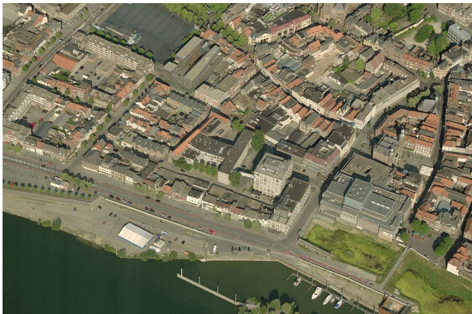
Luchtfoto plangebied voor aanvang (sloop)werkzaamheden (BING maps, 2011)
