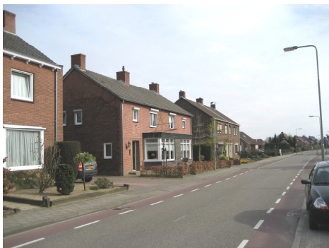
Afbeelding 3: Lintbebouwing aan de Schoolstraat
