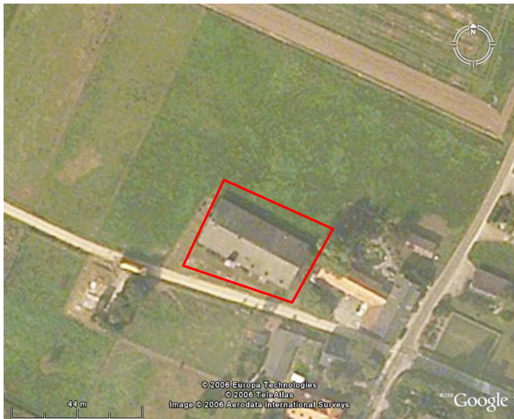
Figuur 4. Locatie 3: Stapperstraat, sloop varkensstal
