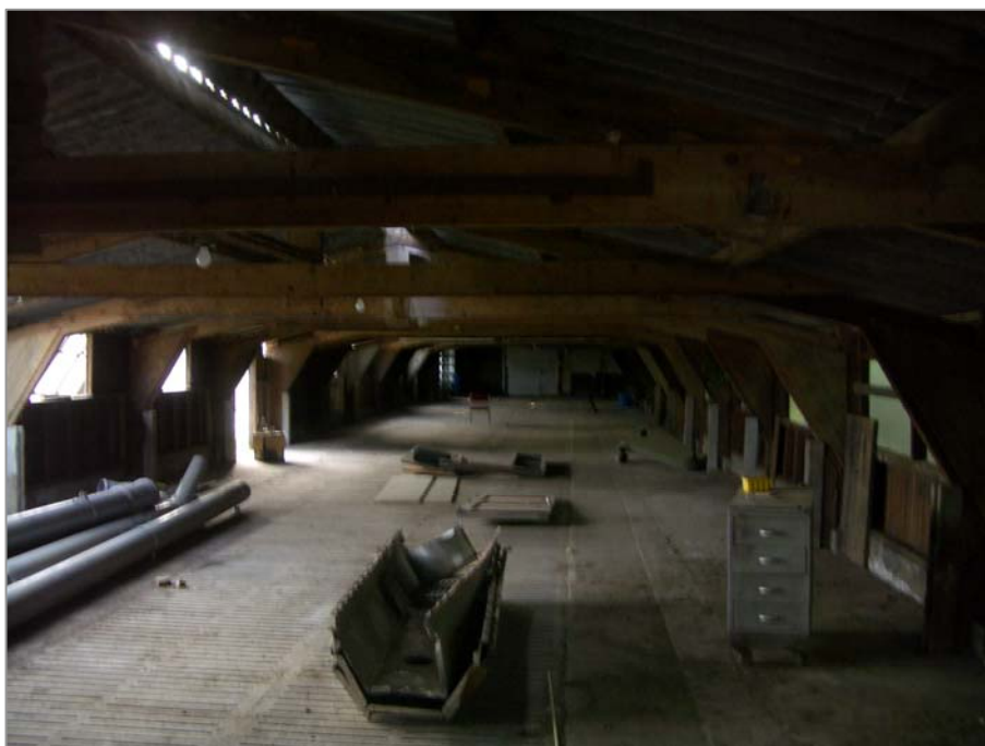
voormalige veestal; thans opslag
