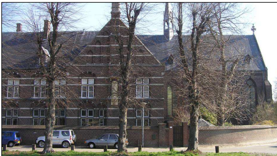
Voormalig slotklooster Mariadal aan de Schoolweg
