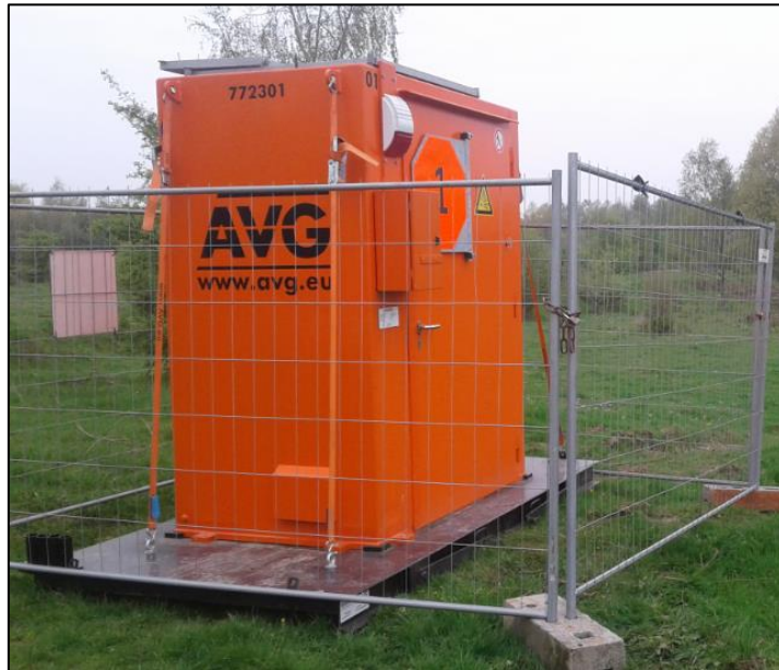
Afb. 7 – Voorziening voor het Tijdelijk Veiligstellen van de Situatie (VTVS)
