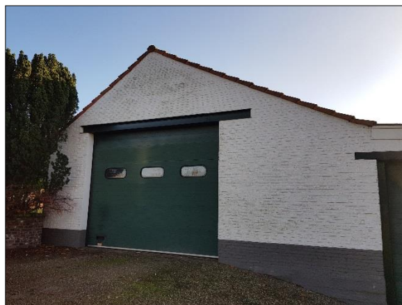
Figuur 5. Zijkant bestaande woning gezien vanaf noorden
