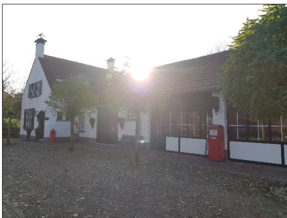
Figuur 4. Bestaande woning gezien vanaf Luuschweg
