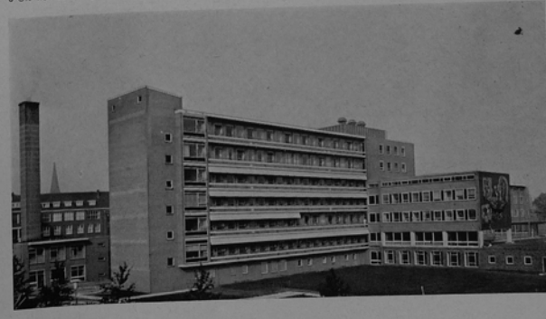
6 Uit het zuiden gezien
