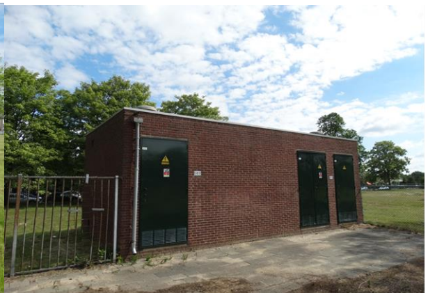
Figuur 8: Transformatorhuisje en bestrating
