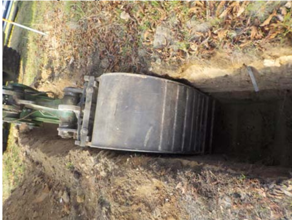
Foto 35. Graafmachine met smalle bak
