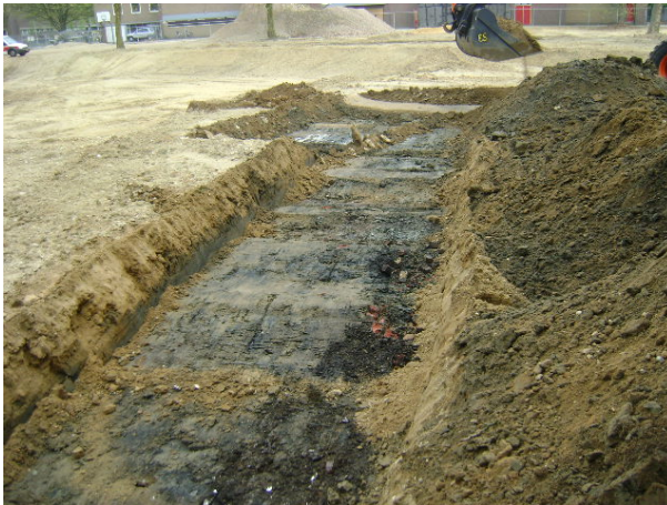
Foto 7: Stortmateriaal in sleuf 6.
