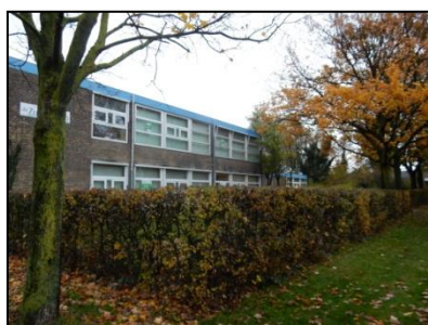
Figuur 3. Noordwestelijke zijde voormalige school (gebouw 1).
