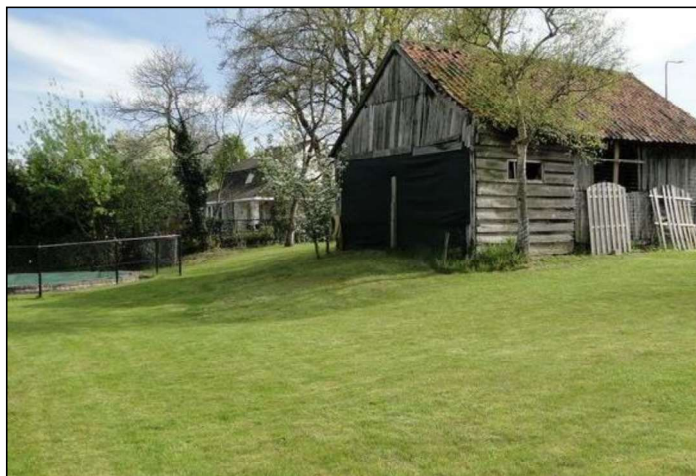
Figuur 5: Zicht op voormalige schuur in noordoosthoek van perceel 12108. De foto illustreert het verschil in hoogte binnen het plangebied. Het hoogteverschil is opvallend en is deels natuurlijk, maar deze 'heuvel' is opgebracht. Bron: Brouwers makelaars.
