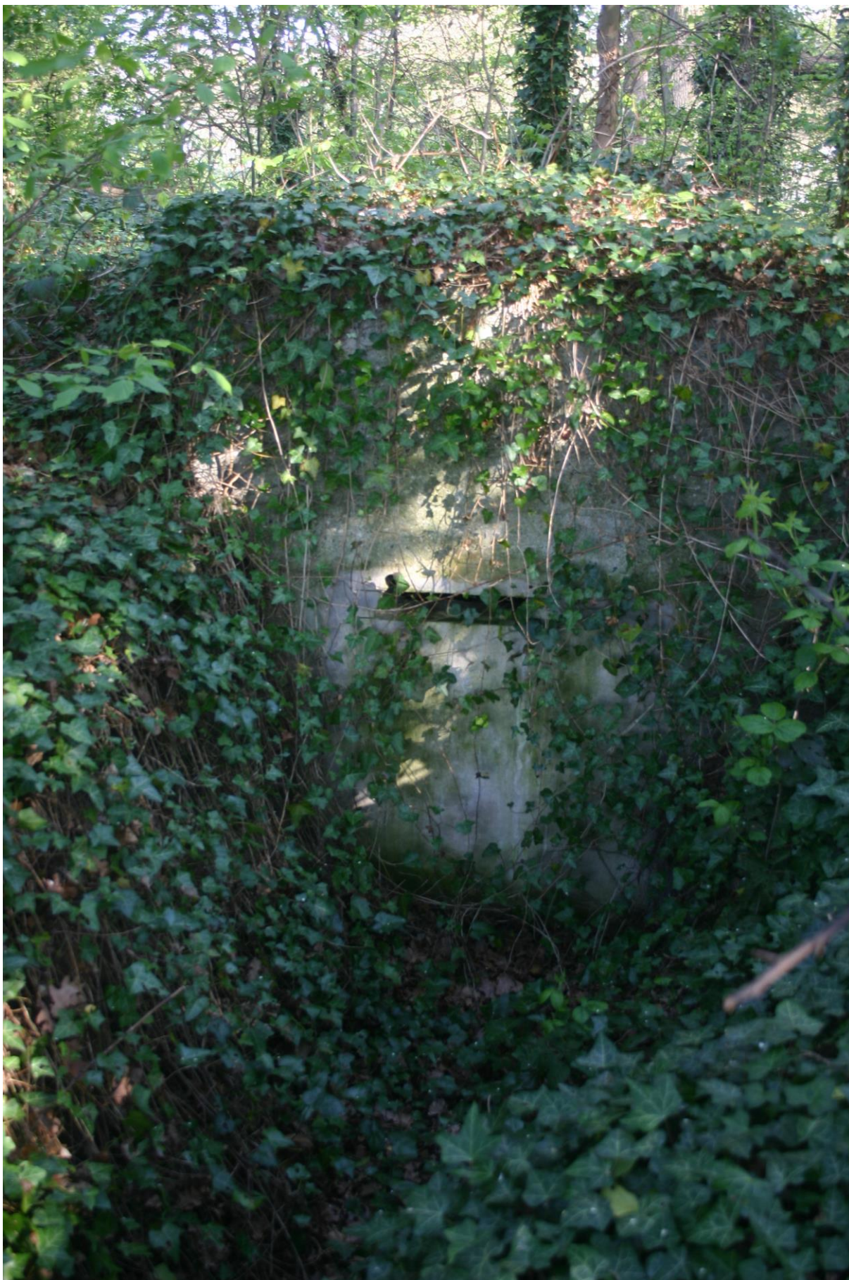
Figuur 5. De met klimop overwoekerde bunkeringang.
