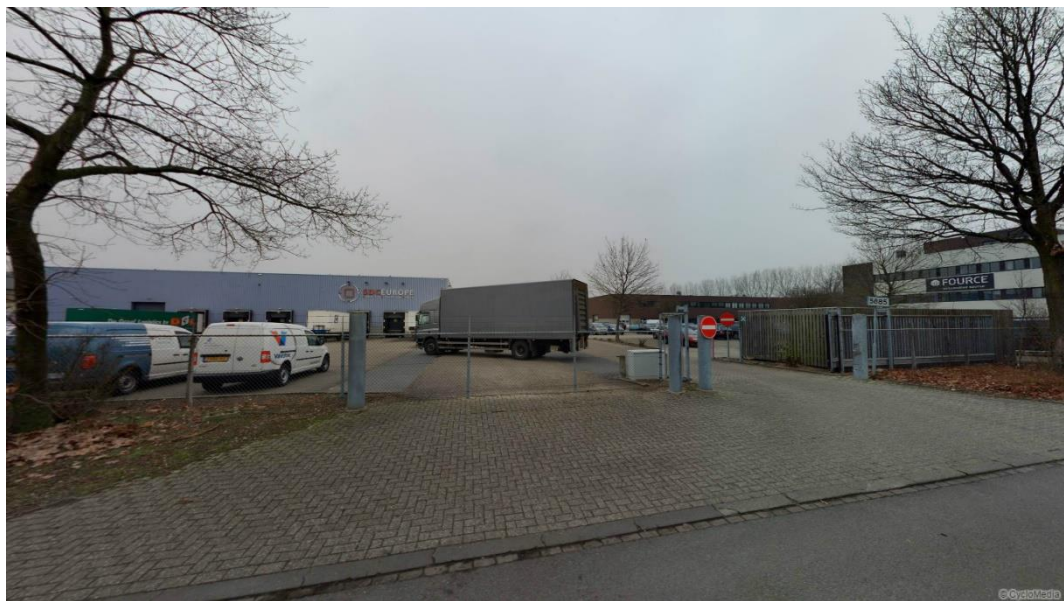
Figuur 8. Huidige bebouwing uitbreidingslocatie
