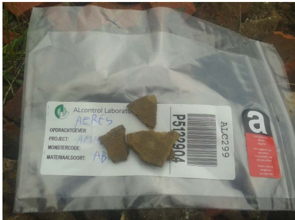
Afbeelding 4: asbestverdacht plaatmateriaal (materiaalmonster ABV-2)
