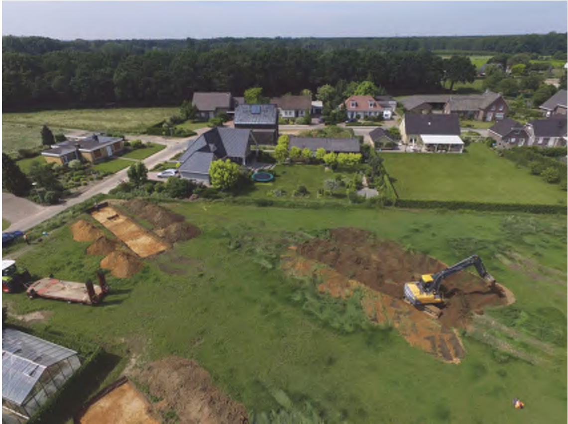
Fig. 4.2: De graafmachine gooit werkput 2 dicht (fase 2).
