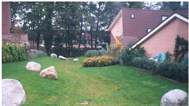
Afbeelding 6: Voorbeeld infiltratiegreppel tussen woningen
