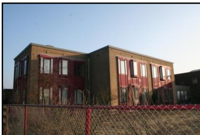
Figuur 6. Achterzijde voormalig schoolgebouw.
