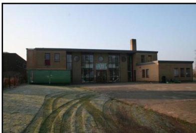
Figuur 3. Voormalig schoolgebouw.
