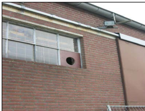
Foto 3: detail bestaande bebouwing
