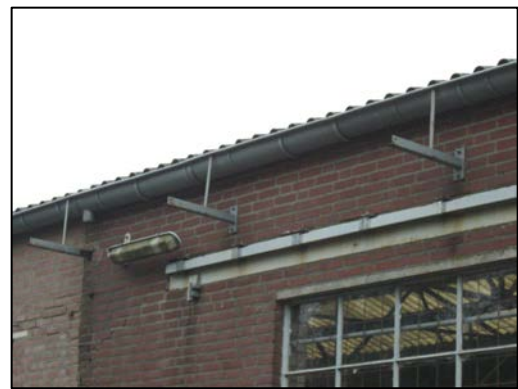
Foto 4: detail bestaande bebouwing
