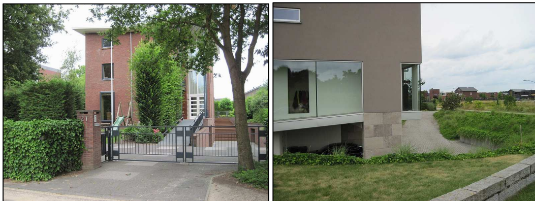
Foto 8. en 9. Opgetilde woningen (Hinsbeckerweg 21 en Jos Klijnenstraat 32)
