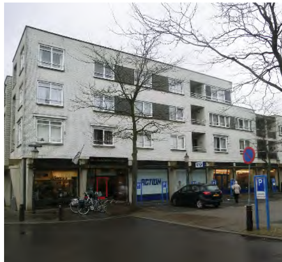
Bebouwing westzijde Carleysplaats
