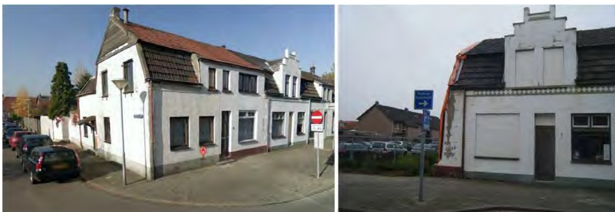
Afbeelding 1. Links: Foto (bron: Google Streetview) van voormalige bebouwing Rechts: foto huidige situatie (d.d. 18 november 2013)
