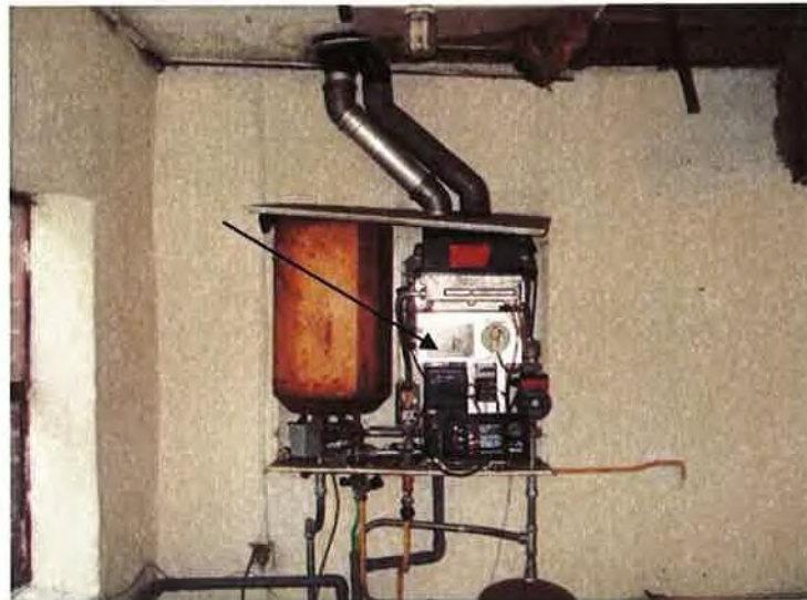
Foto 11: asbestvrije CV-ketel in de berging van Steegstraat 30.
