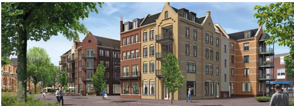
Foto's bestaande situatie Wilhelminaplein (Croonen Adviseurs, 2012) en impressie nieuwbouw ( www.cordistegula.nl )
