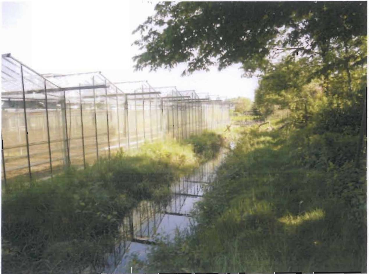
Foto 5: ten zuidoosten van de tuinderskas gelegen infiltratiesloot voor hemelwater (14 mei 2012)
