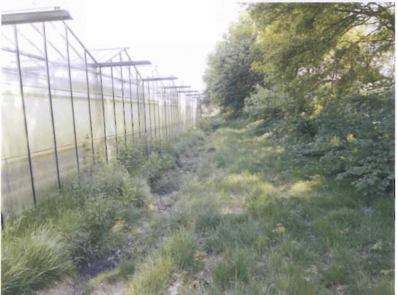
Foto 4: ten zuidoosten van de tuinderskas gelegen infiltratiesloot voor hemelwater (14 mei 2012)
