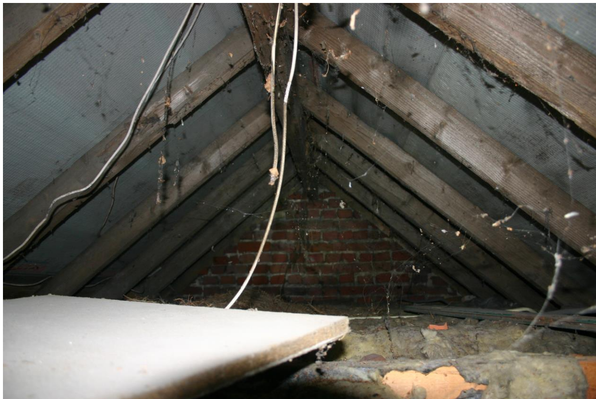
Figuur 6. Onder de dakpannen van het woonhuis is dampwerende folie bevestigd.
