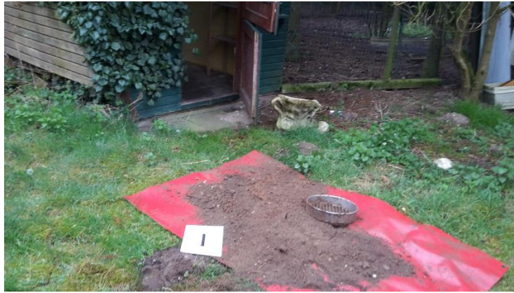
Foto 4: uitkomende grond inspectiegat 1 (5 april 2016)
