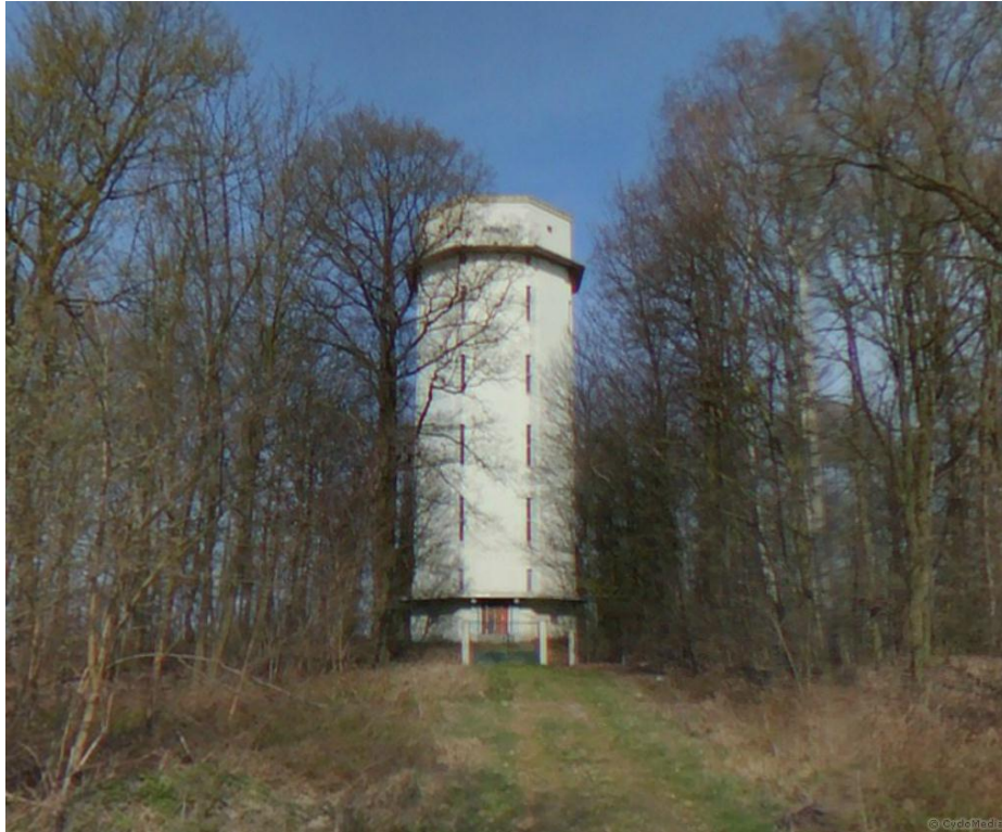
Abbeelding 2: de watertoren aan de Egipte is een Rijksmonument.
