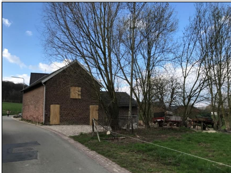
Bestaande situatie (schuur)
