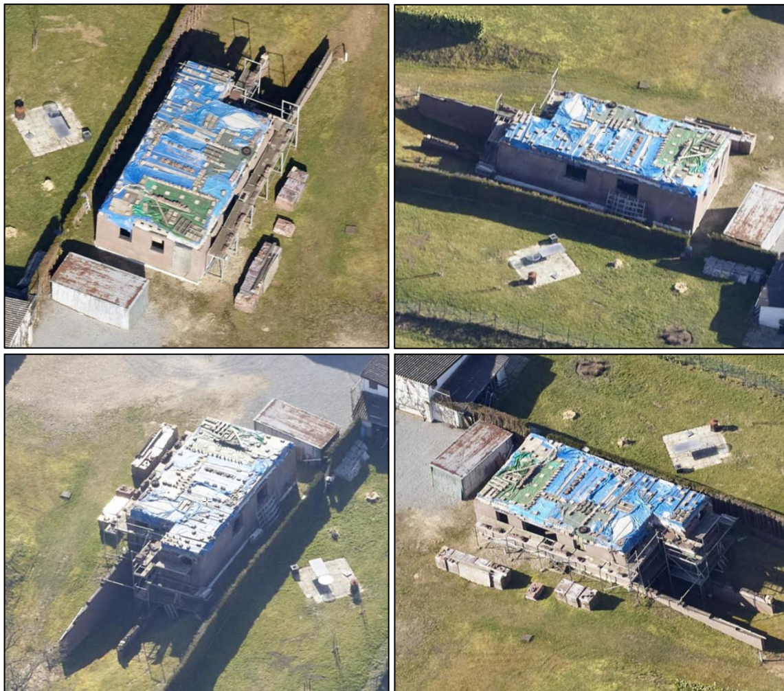
Foto's bestaande situatie
