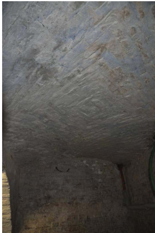
Kelder onder de achterste woning (XIXB)
