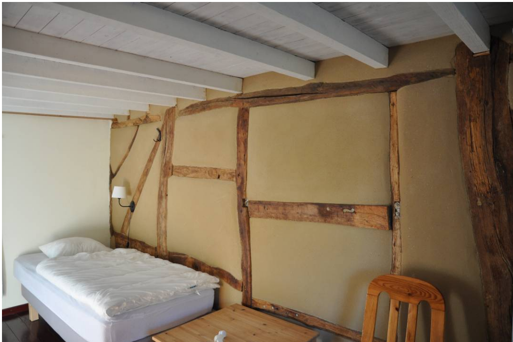
De interne vakwerkconstructie van de zuidelijke vleugel
