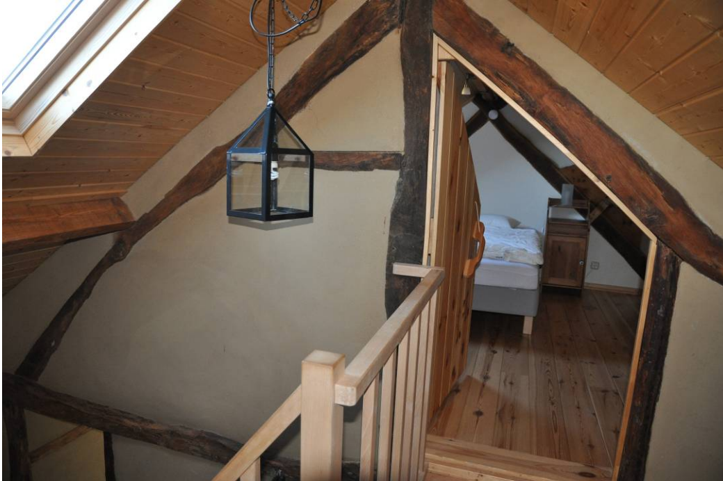
Interne vakwerkwand in de achterste woning, met twee kasspanen
