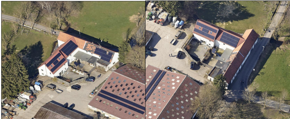
Foto's bestaande situatie Oude Akerweg 12a/12b Vaals
