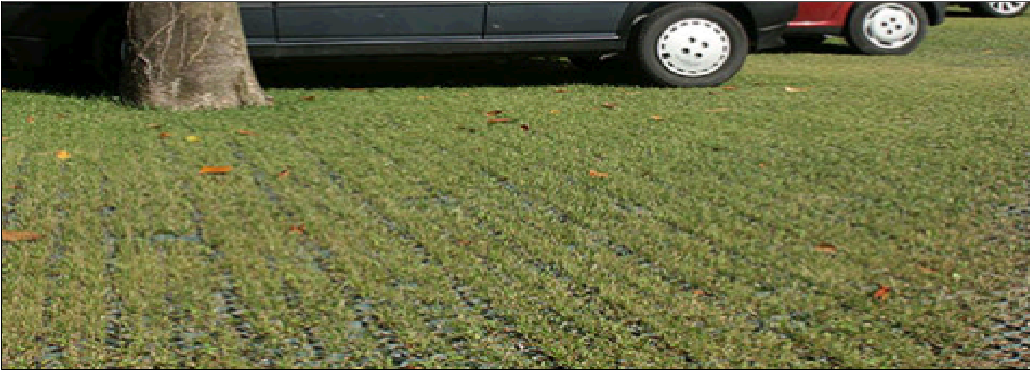
open verharding met duidelijk patroon tbv. aanduiding parkeerplaats, bijvoorbeeld kunststof infiltratieroosters / gazonbeschermingsnet met gras of mos
