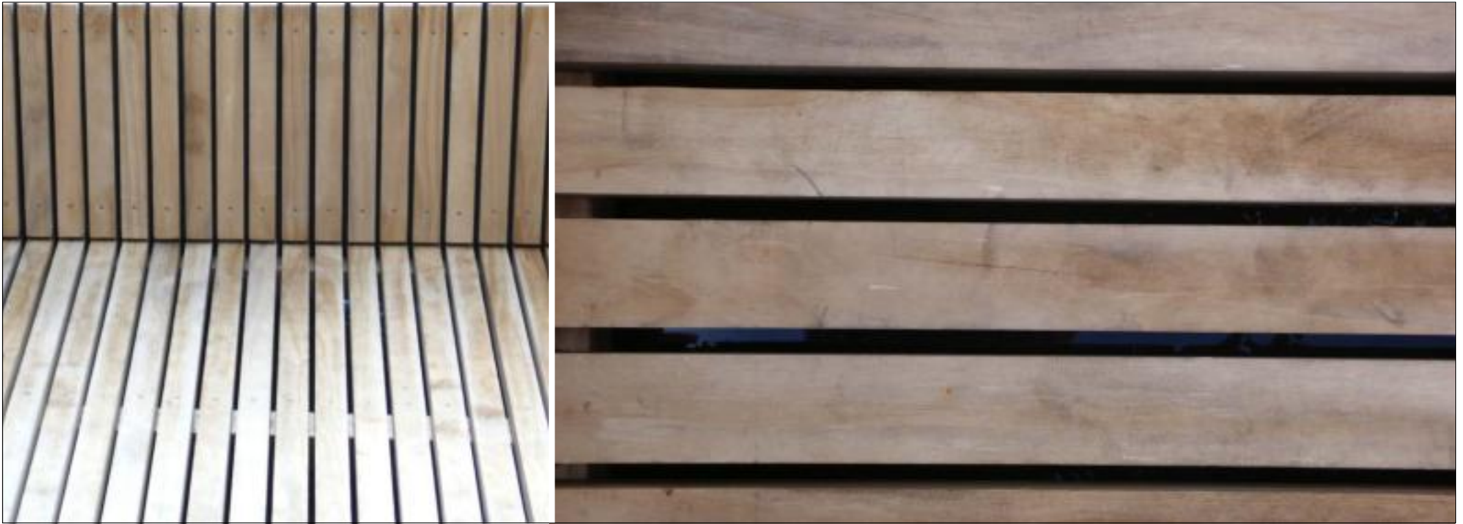
bruug oversteekplaats en balustrade in hout
