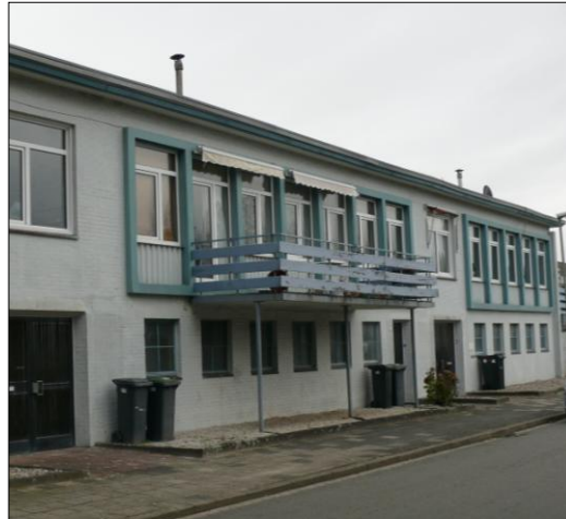
Impressie plangebied: bedrijfsbebouwing
