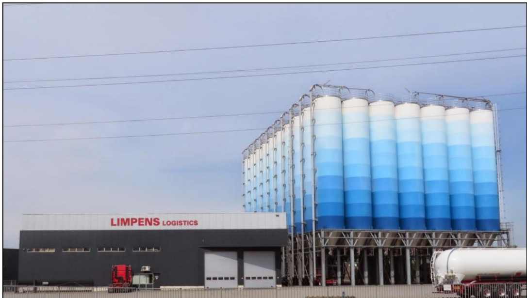
De bestaande silovoorziening (70 silo's) bij het bedrijf, gezien vanuit oostelijke richting)
