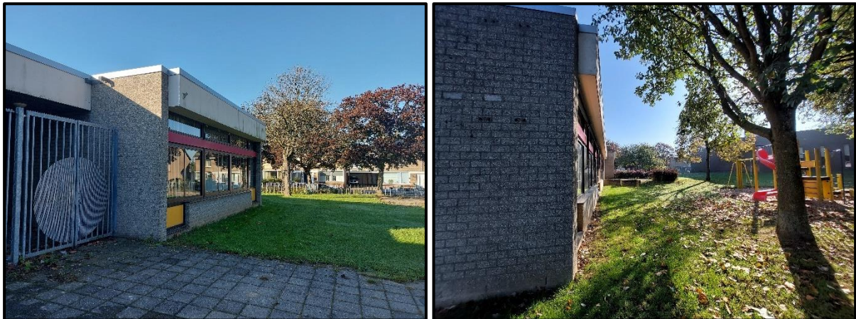
Figuur 2.2 Weergave van de school met zichtbaar de zonneschermkasten boven de ramen.
