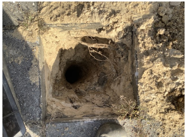
Foto 14 Inspectiegat ter plaatse van boring 05
