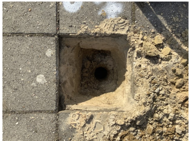
Foto 16 Inspectiegat ter plaatse van boring 07
