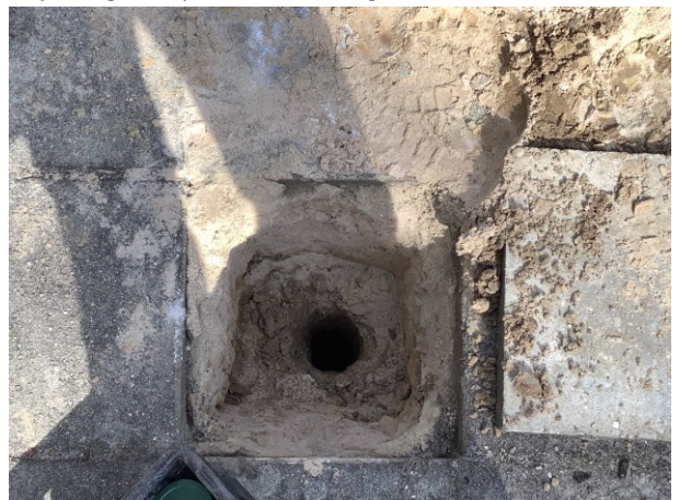
Foto 18 Inspectiegat ter plaatse van boring 12
