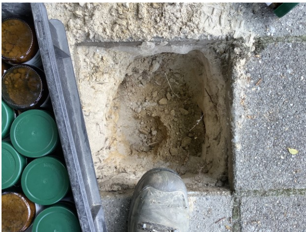
Foto 15 Inspectiegat ter plaatse van boring 06
