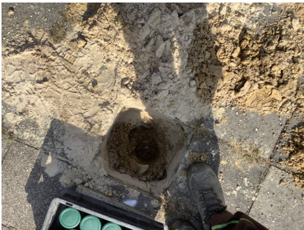
Foto 13 Inspectiegat ter plaatse van boring 04
