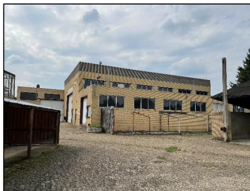
Foto 2. Zijkant voormalige bedrijfsloodsen en open 'fietsenstalling' (links), gezien vanuit het oosten
