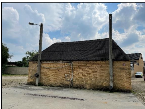
Foto 3. Voormalige onderhoudsplaats materialen midden in het plangebied, gezien vanuit het noorden
