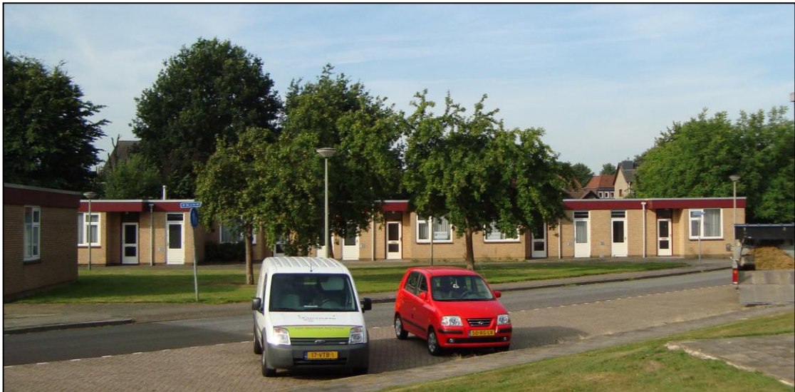
Figuur 1.4: de voormalige bebouwing in het plangebied, gezien vanaf de Stegelenhof
