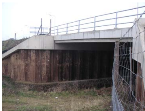
Afbeelding 5: Faunatunnel onder de N271.
