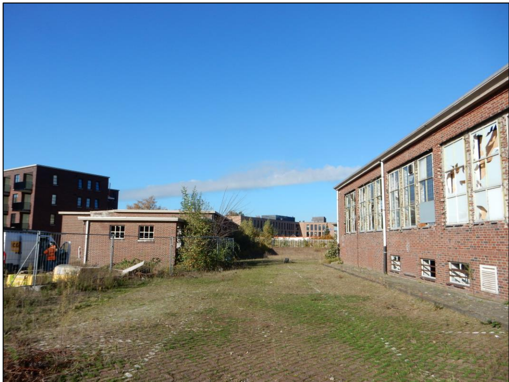
Figuur 4 De planlocatie. Rechts: de Eiermijn. Links: bijgebouw 2 waarachter bijgebouw 1 is gesitueerd.
