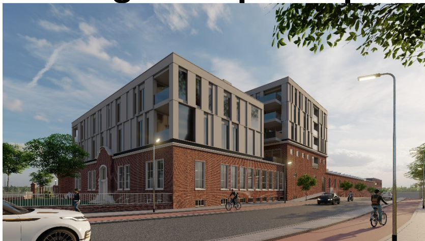
Transformatie voormalige Eiermijn Roermond
