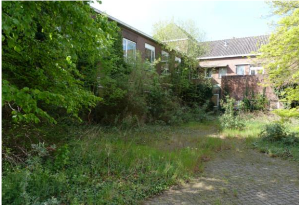
Fig. 9. Noordwestelijk deel binnenplaats, kijkrichting West
