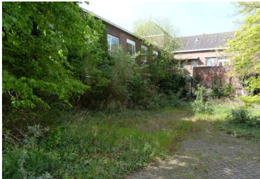
Foto 5. Noordwestelijk deel binnenplaats, kijkrichting West
