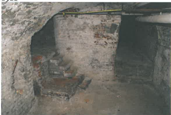
Het samengestelde, laat-middeleeuwse kelderplan onder het pand Lindanusstraat 2 vormt een nagenoeg gaaf behouden opzet die teruggaat tot de oorspronkelijke bebouwingsstructuur van de Lindanusstraat (XIV-XVI). De monumentale kwaliteit is hoog
