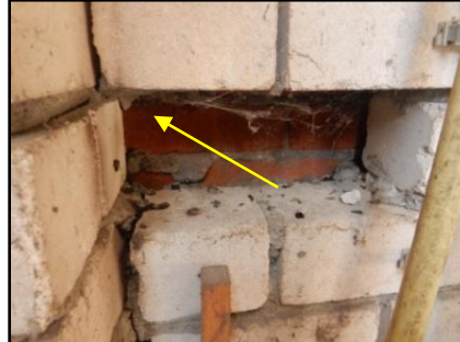
Figuur 12. Geschikte toegangsmogelijkheden om toegang tot de ruimte tussen de muren.
