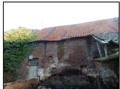
Figuur 5. Achterzijde bebouwing.
