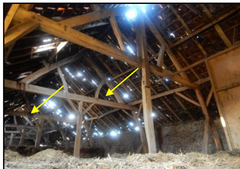
Figuur 10. Potentiële nestlocaties op de balken van de zolder van de koeienschuur.
