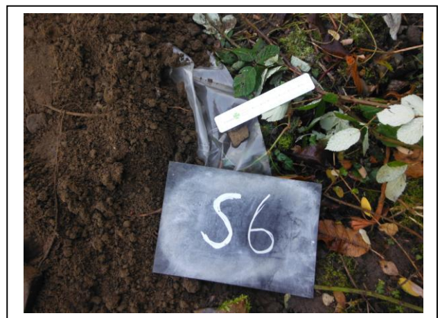
Foto 16. Aangetroffen asbestverdacht materiaal sleuf S06
