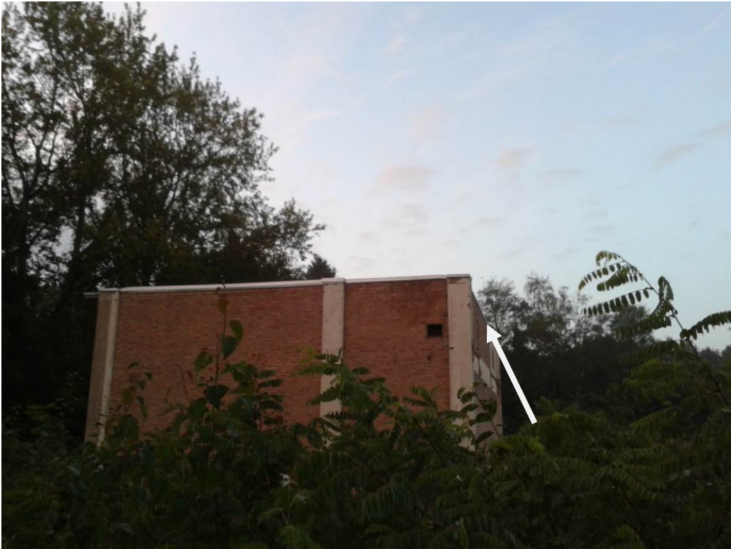
Figuur 3-1: invlieglocatie ca. 5 gewone dwergvleermuizen, gezien op 26 juni rond 5:00 uur. Ze verdwenen onder de aluminium daklijst aan de westzijde van het trafohuisje. De witte pijl wijst de invlieglocatie aan.
