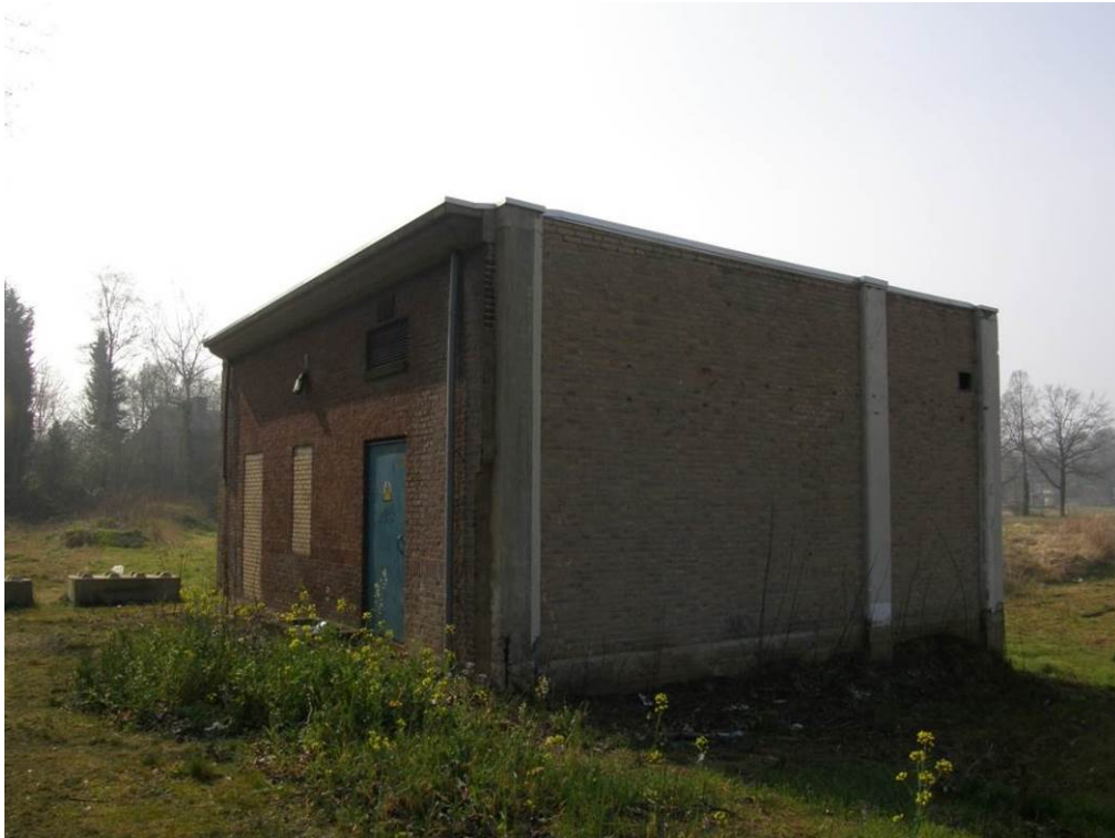
Figuur 2-2: Het te onderzoeken gebouw, een trafohuisje aan de noordostrand van het plangebied. Dit gebouw heeft geschikte invliegopeningen voor vleermuizen, bijvoorbeeld langs de regenpijp.
