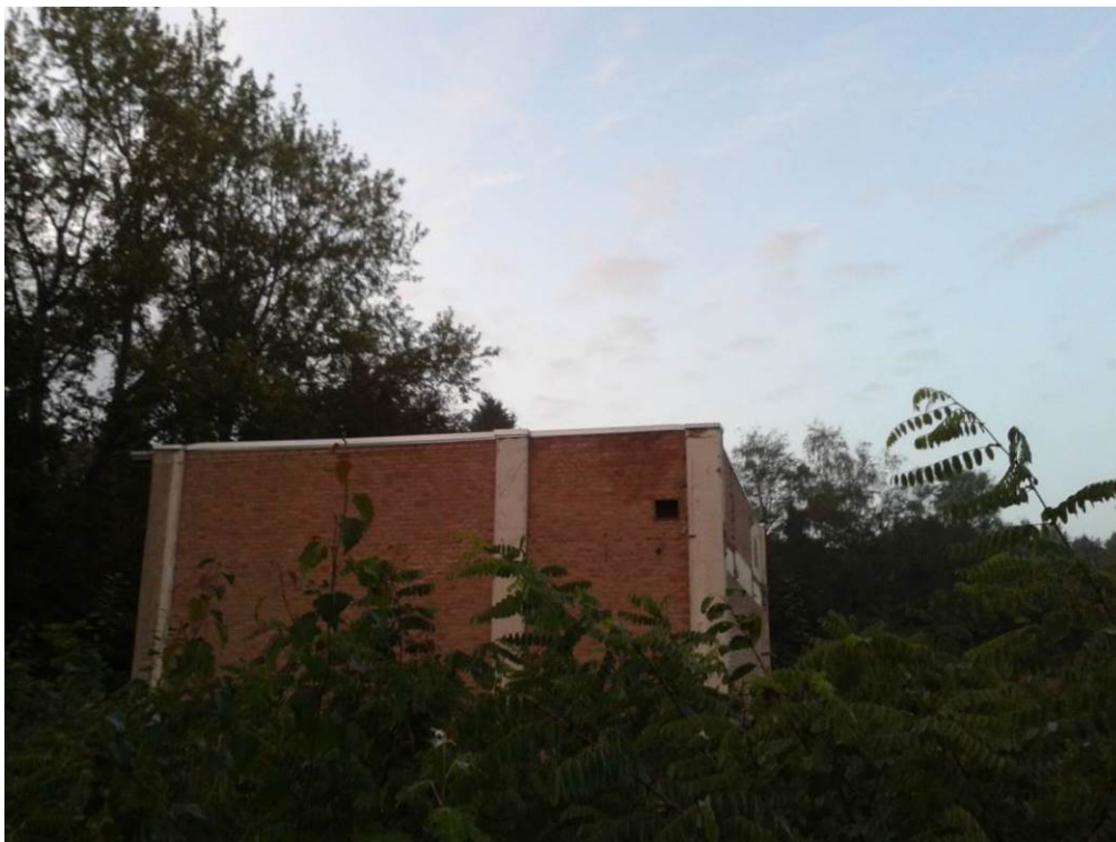
Figuur 2-3: Het trafohuis gezien vanaf de noordzijde. Vleermuizen kunnen wegkruipen onder de aluminium strip van het dak.
