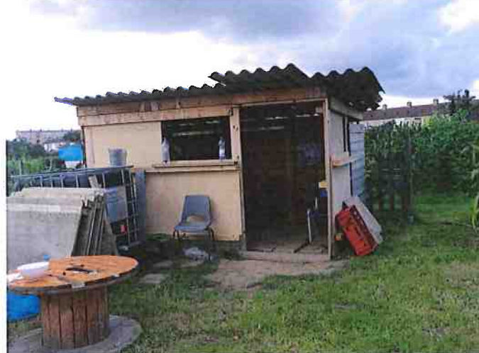
foto 10 nieuw schuurtje met niet-asbesthoudende golfplaten
